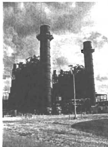
HRSG and Stack at Stanton Unit B
