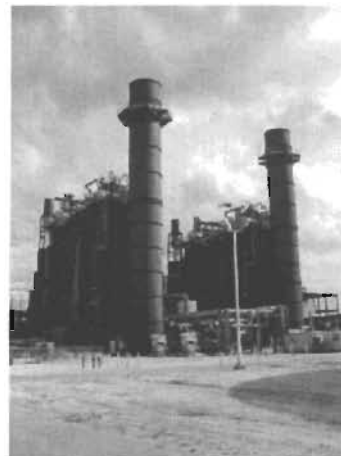
HRSG and Stack at Stanton Unit B
