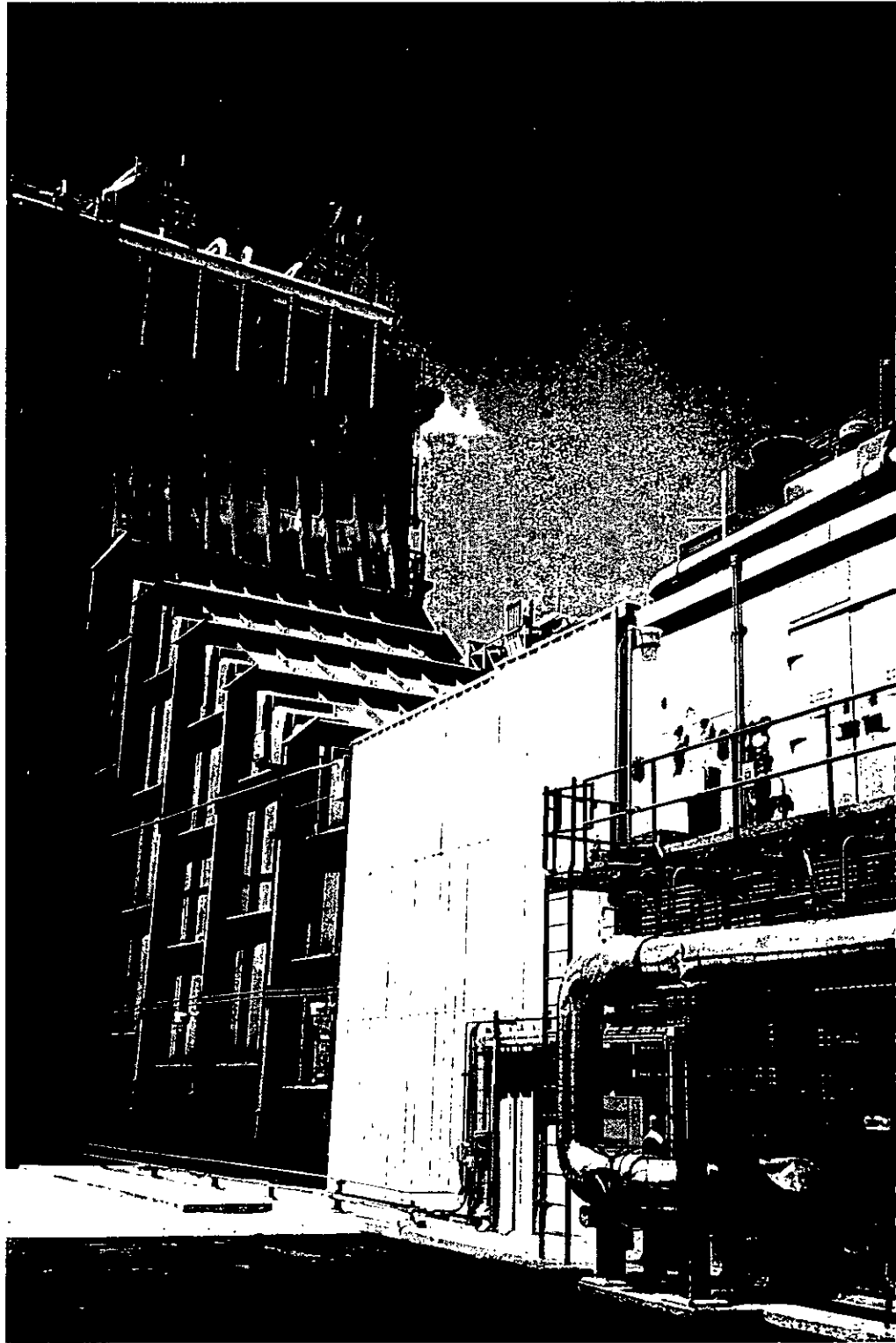
Unit 5A CT Exhaust/HRSG Inlet
