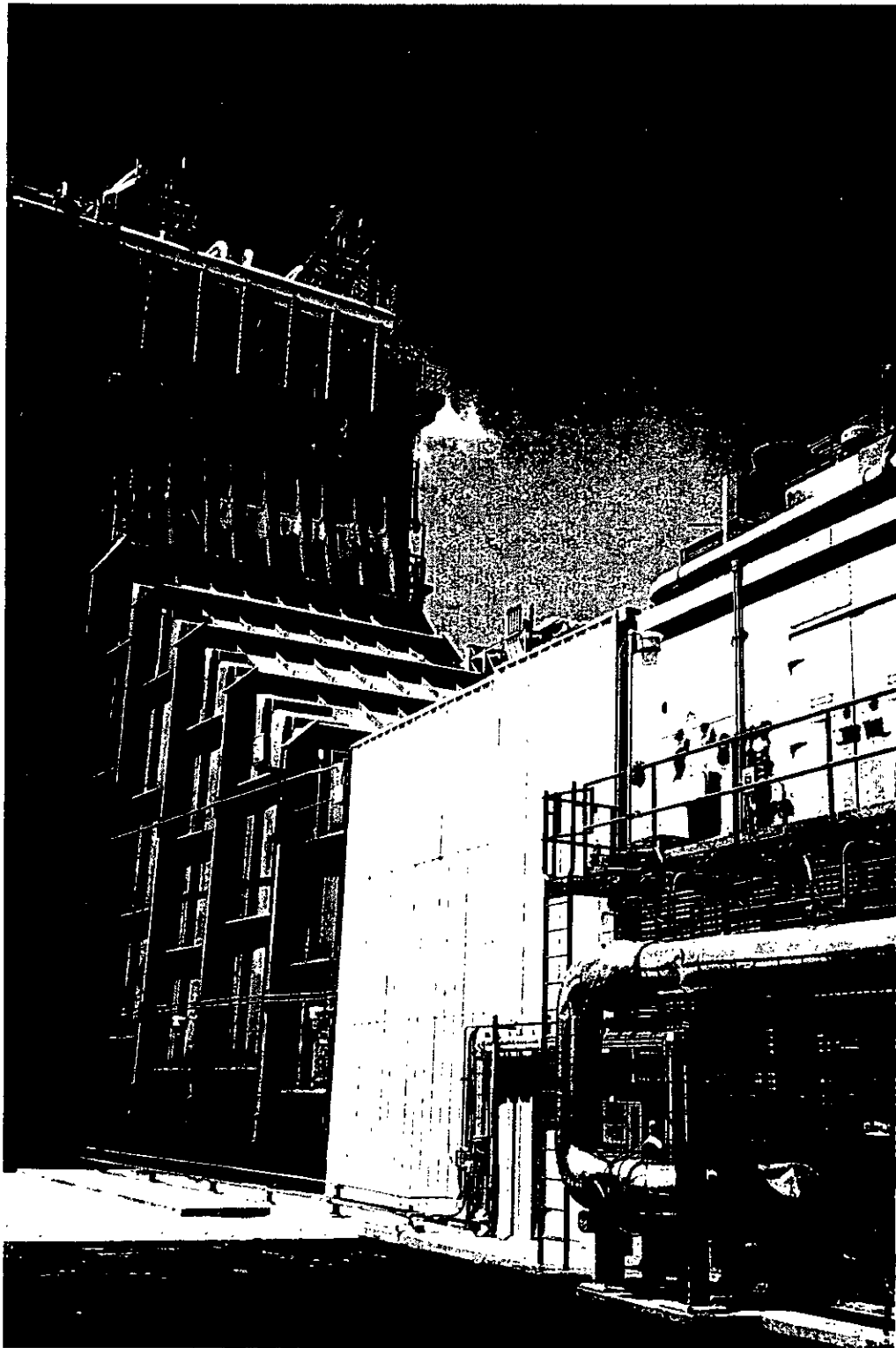
Unit 5A CT Exhaust/HRSG Inlet
