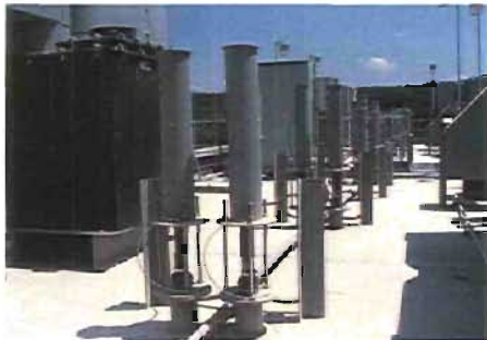
ESI Rappers on precipitator roof
