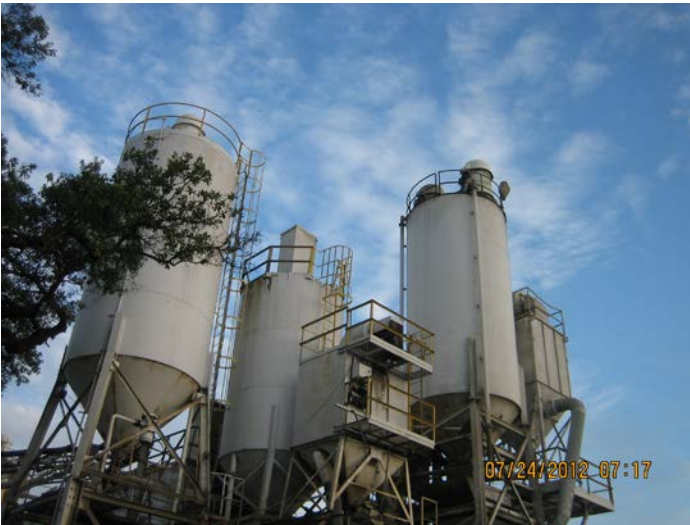
Photo ID No: IMG_425 – B. E. T. ER Mix, Inc. Ready Mix Plant
