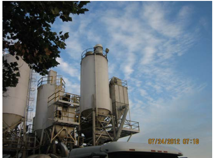
Photo ID No: IMG_426 - B. E. T. ER Mix, Inc. Ready Mix Plant
